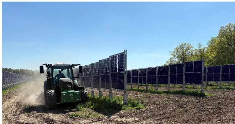
Eine Agri-PV-Anlage ermöglicht eine gleichberechtigte Doppelnutzung der landwirtschaftlichen Lebensmittelproduktion bei gleichzeitiger Stromerzeugung. Die Ausführung erfolgte als bifaziale (beidseitig nutzbar), senkrecht stehende Photovoltaikanlage in Ost-West-Ausrichtung, bei der die Module auch direkte Sonneneinstrahlung auf der Rückseite in Strom umwandeln. © Stadtwerke Buchen GmbH & Co KG
